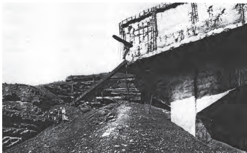
Рис. 3. Сопряжение путепровода с насыпью
