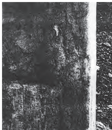
Рис. 1. Растрескивание защитного слоя арматуры из цементного раствора на стойках рамы
