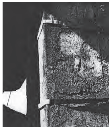
Рис. 2. Скалывание углов стоек рамы
