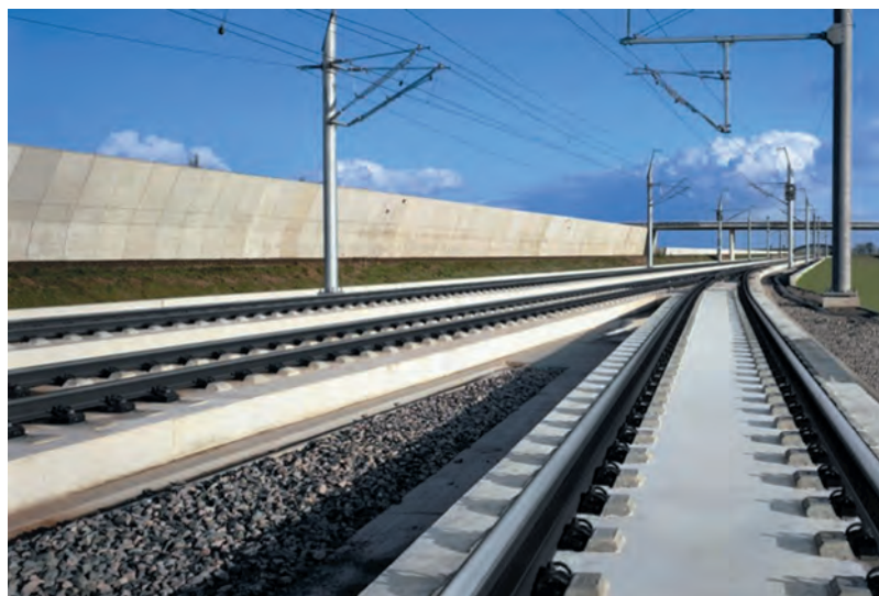
Рис. 3. Безбалластный путь для высокоскоростного транспорта
